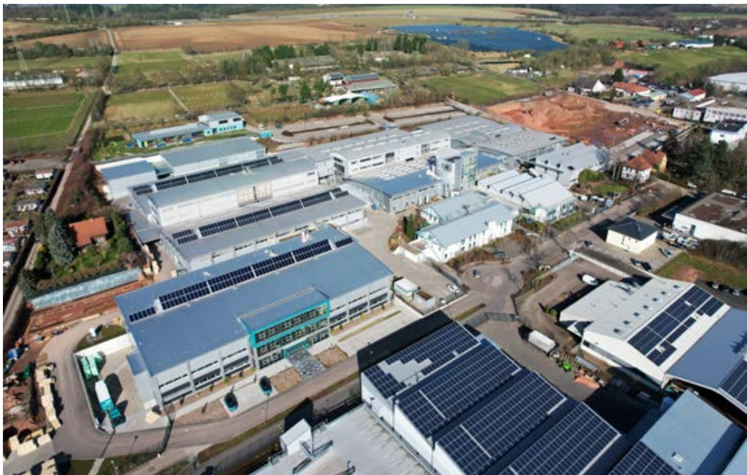
Sede centrale Wipotec
